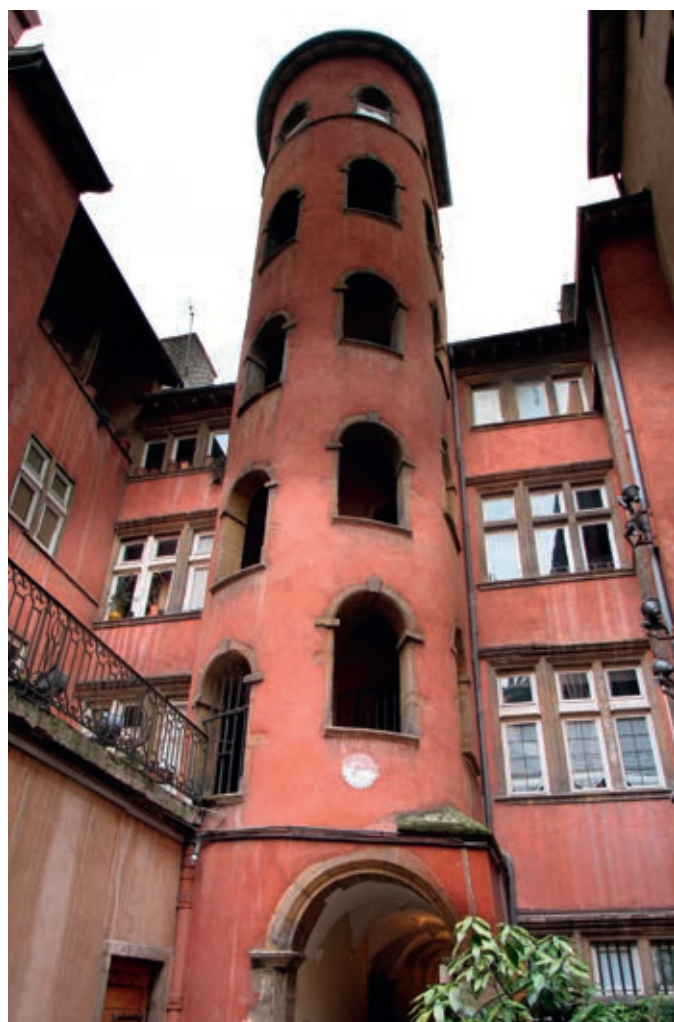
La traboule de la Tour Rose à Lyon.
